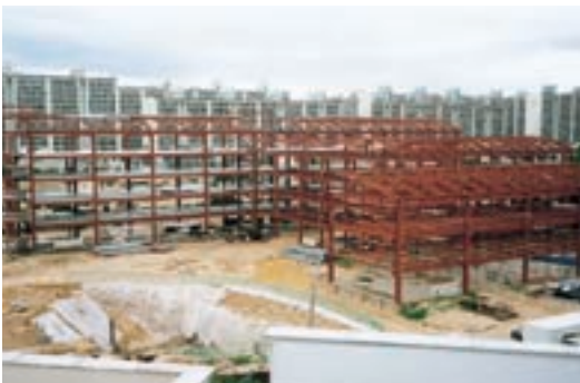
Figure 5.17 보 설치 완료
